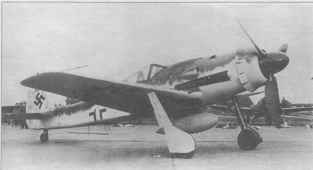
Ранний серийный Fw 190D-9 (W.Nr. 210051) выпущенный заводом в Лангенхагене. Самолет оснащен фонарем раннего типа и подвесным баком объемом 300 литров.
